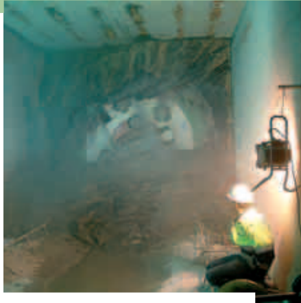
Der Stollendurchstich am 30. März 2008
