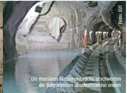
Rohr für Rohr wurde die Stahlrohrleitung im Stollen zusammengesetzt.
